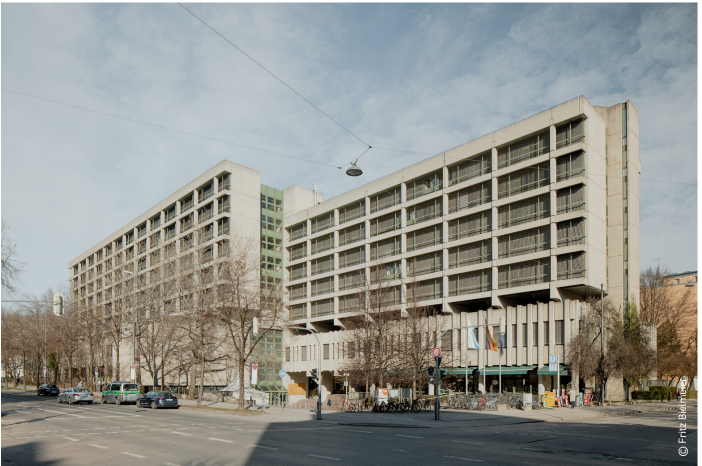
Das Straßjustizzentrum an der Nymphenburger Straße
