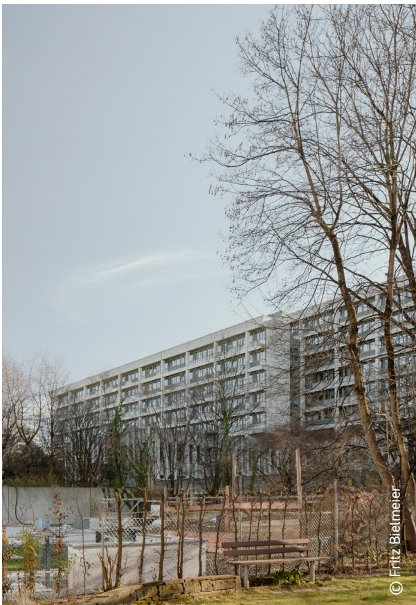
Rückseite des Gebäudes
